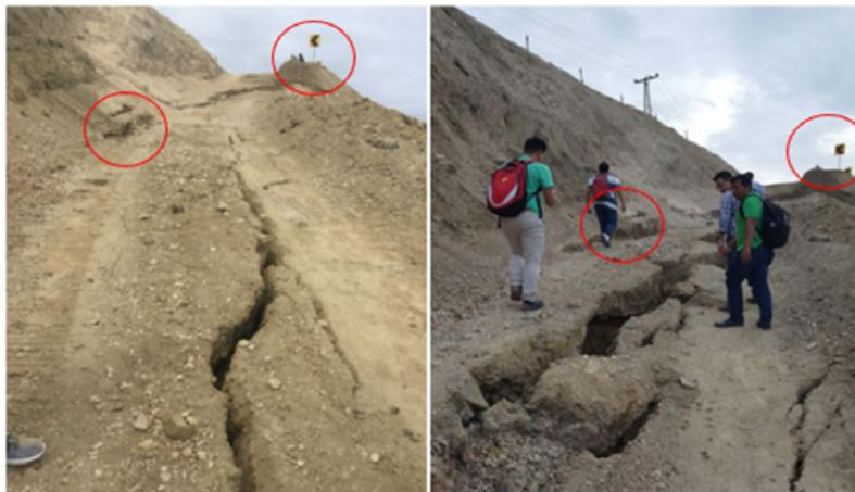
Figura 7: Fisuras en el talud, foto el 10/01/2018 y su desplazamiento después de 5 días, observar la referencia de los círculos rojos.
