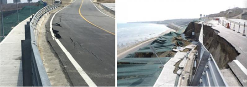
Figura 5: Fisuras en la vía presentadas después del sismo del 05/12/2017 y su posterior deslizamiento.
