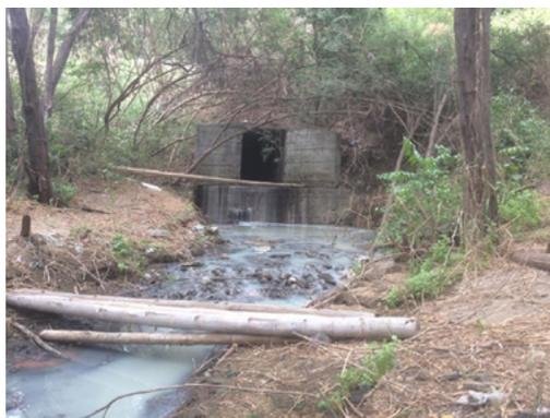
Figura 1: Descarga de aguas residuales en la Alcantarilla de Cajón.
