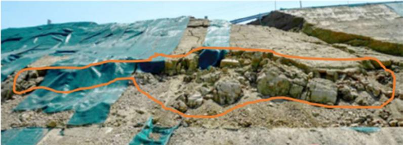
Figura 6: Deslizamiento ocurrido días después del sismo del 05/12/2017, nótese el hinchamiento del pie con la presencia de lutitas.
