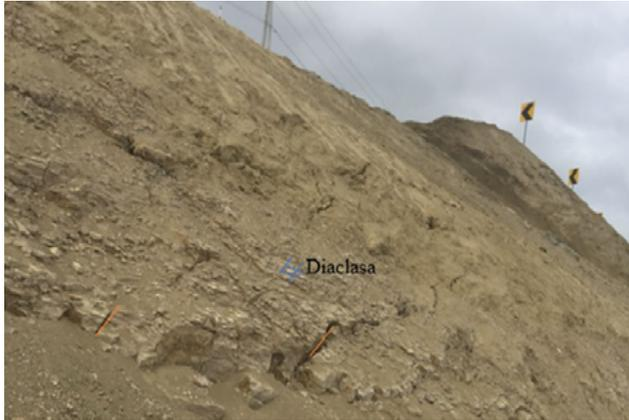
Figura 3: Talud 0+070, lutitas fuertemente diaclasadas, con presencia de fracturadas.
