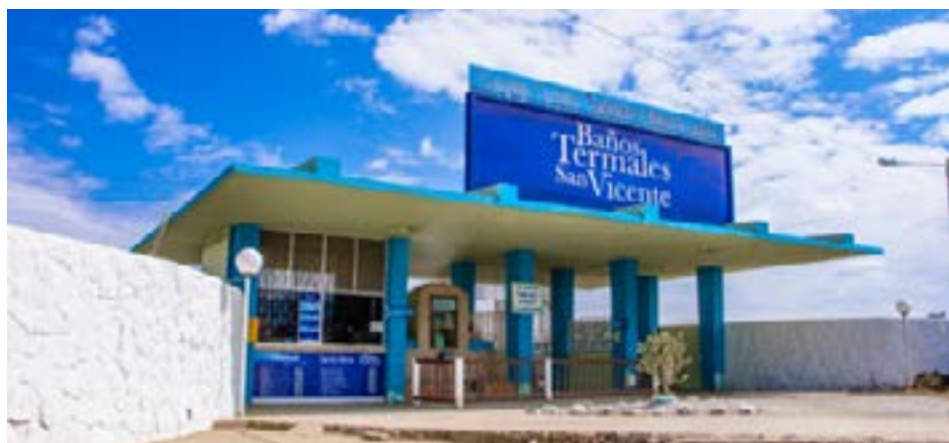
Figura 3. Exteriores del Complejo Baños Termales de San Vicente. Fuente: EMUTURISMO (s.f.).
