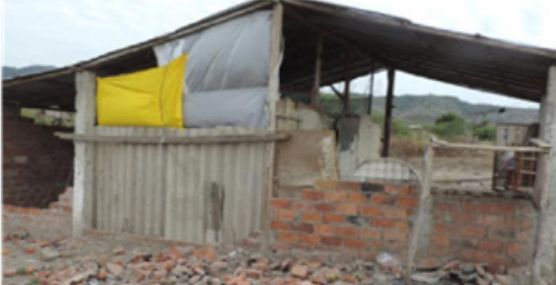
Figura 82. Las columnas sin los estribos adecuados y sin arrostramiento a nivel de cubierta, al momento del terremoto, destruyeron las paredes adosadas a ellas y permitieron la catástrofe. Fuente: Archivo de Bojorque-Construcciones.
