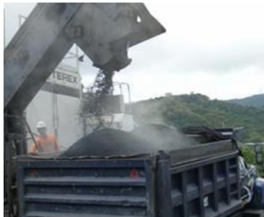
Ilustración 18: carga de mezcla asfáltica
