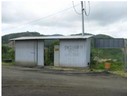
Ilustración 24: Área donde se ubica el generador
