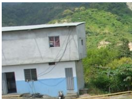
Ilustración 22: Oficina e instalaciones para guardiana
