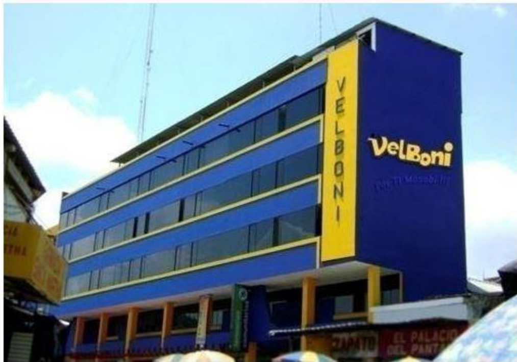
Matriz en Tarqui, funcionó hasta el 16 de abril de 2016, luego del terremoto, por los daños en su estructura, fue derrocada.
