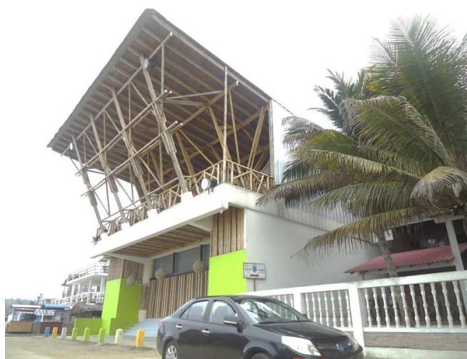
Figura 51. Infraestructura de Servicios borde Costero Comuna Montañita, Ecuador.
