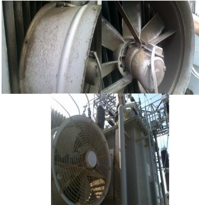
*Figura 17. Deposición del polvo de las canteras en los ventiladores de la subestación.*
