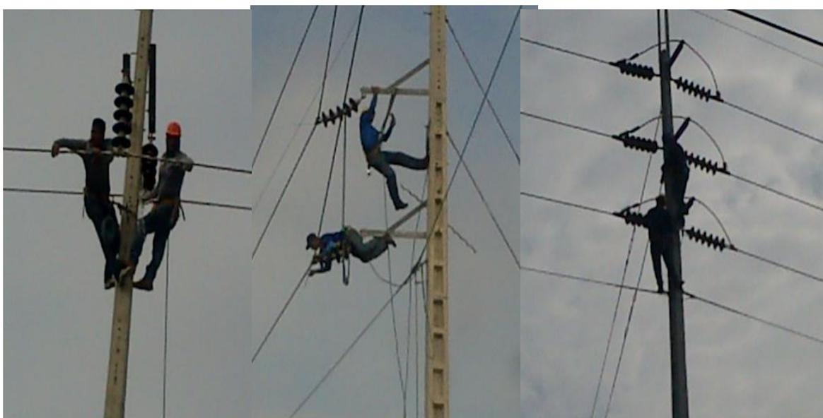
*Figura 19. Operarios eléctricos limpiando y dando mantenimiento a las redes.*
