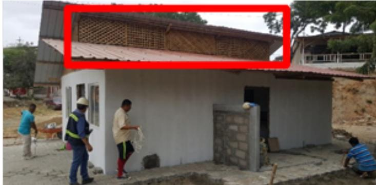
Figura 110. Fachada Lateral Derecha – Efecto Chimenea – Técnica Bioclimática.
