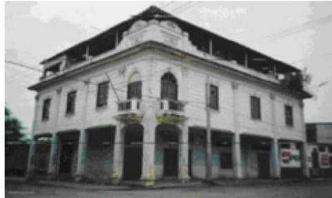
Figura 34. Ex- clínica del IESS en Manta. Construcción realizada en 1920 por los propietarios de la “Casa Tagua”. Es la primera construcción en hormigón armado realizada en la provincia de Manabí, Además, presenta un esquema funcional y formal, estrictamente racionalista. Fuente: Tesis Doctoral (1998)
