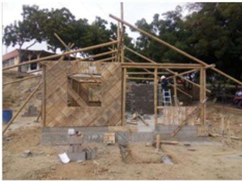
Figura 105. Armado de Estructura Modular – Mamposterías con caña rolliza y malla metálica.
