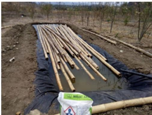
Figura 107. Selección – Perforación e Inmunización dentro de Piscinas.
